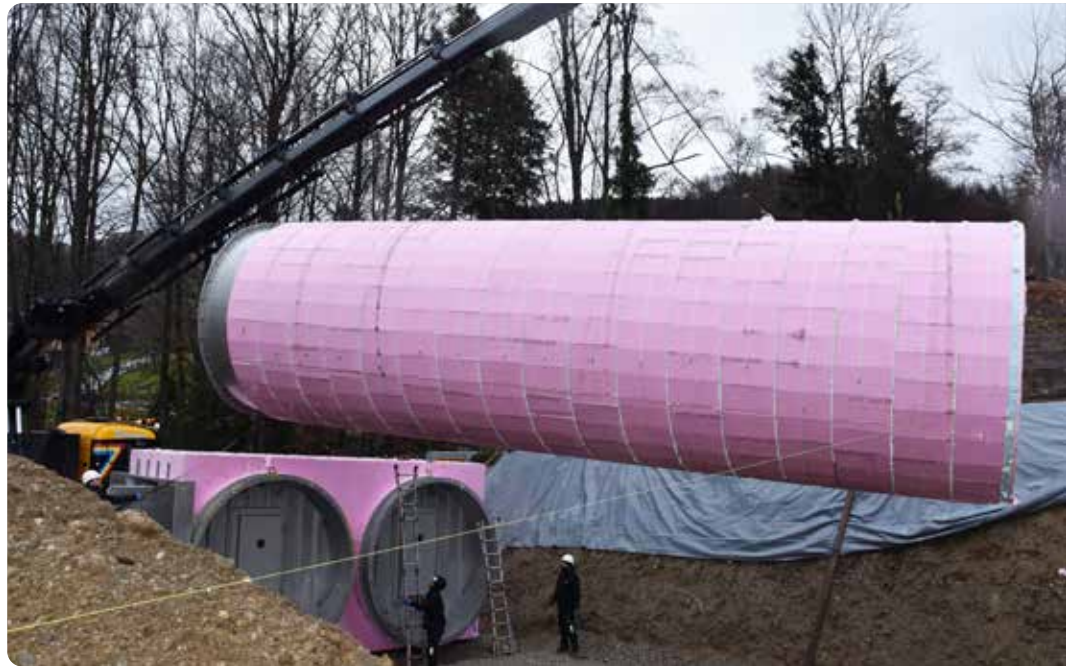
Zwei Behälter mit je 80 Kubikmeter Fassungsvermögen wurden eingehoben und anschließend mit der Trockenkammer verschweißt.
